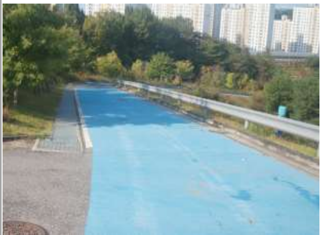
송수-1, 2 종점부 전경
